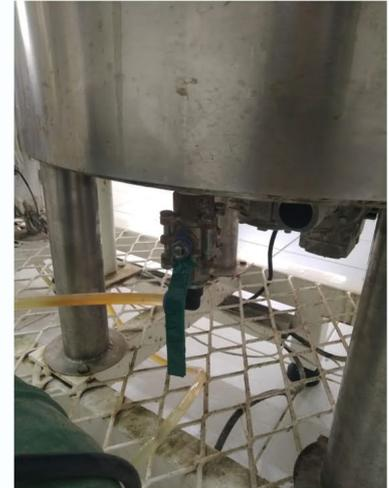
Válvula verde de fundo do reator de hidrólise
