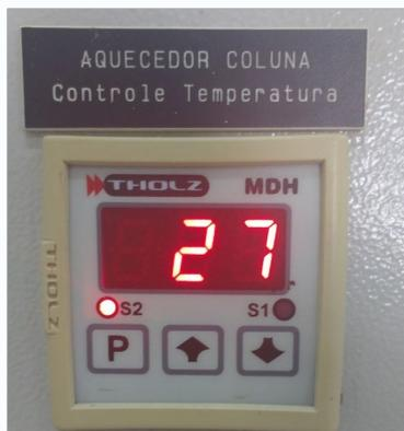
Para iniciar o processo de destilação, é necessário realizar o ajuste da temperatura da coluna de destilação no **“AQUECEDOR COLUNA—controle de temperatura”** pressionando o botão **P** e estabelecendo a temperatura em **100°C através das teclas**. Após o ajuste **↕ ↕** apertar novamente o botão
