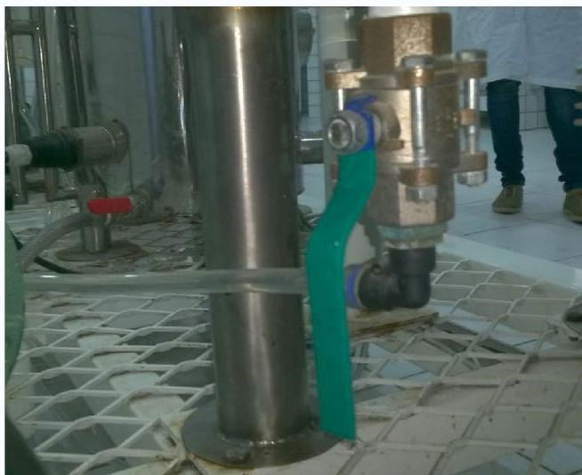
Válvula inferior verde do reator de hidrólise
