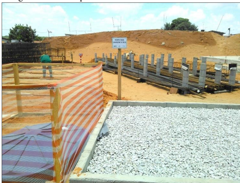
Fotografia 1 – Local para lava bicas no canteiro
