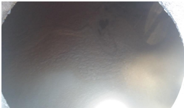
Figura 15. Interior do Tanque de fermentação.
