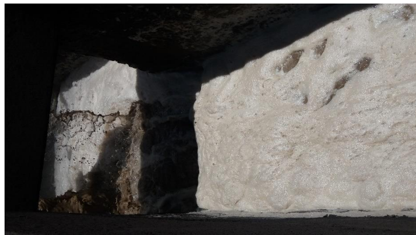
Figura 20. Canal de escoamento da vinhaça.
