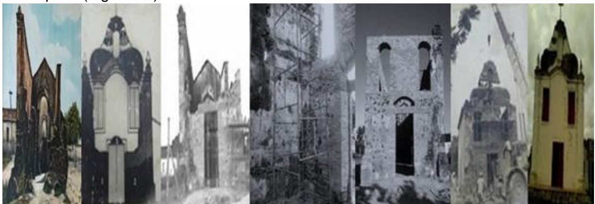
Figura 03 - Processo de soerguimento da atual construção histórica/sacra do extinto Engenho Cunhaú histórico.
