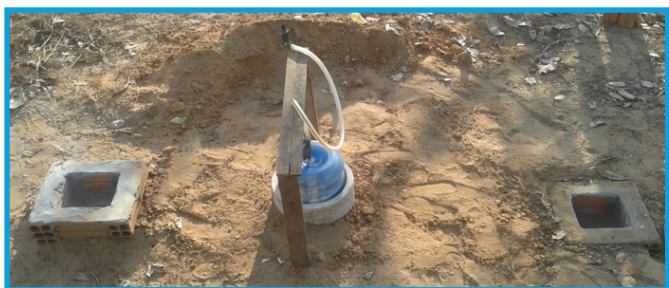
Figura 3 – Biodigestor construído durante a realização do projeto de TCC, na localidade Retiro 1 sitio 3 Irmãos.
