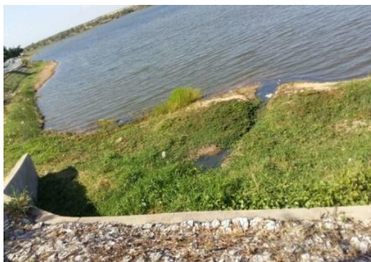
Figura 5: receptação de esgoto sem tratamento
