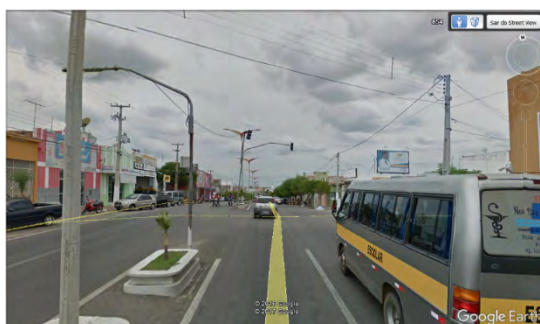
Figura 05 – Ausência de sinalizações verticais
