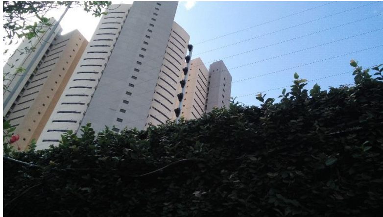
Figura 22: Instalação de cerca elétrica.
