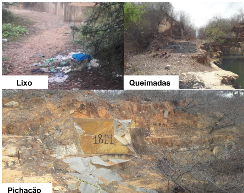
Fotografia 2 - Ações antrópicas na Pedreira do Eco
