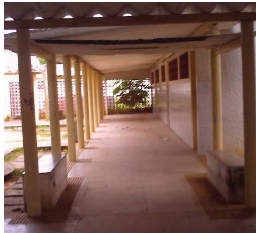
Figura 01 - Nivelamento da Escola e Presença de Piso Tátil
