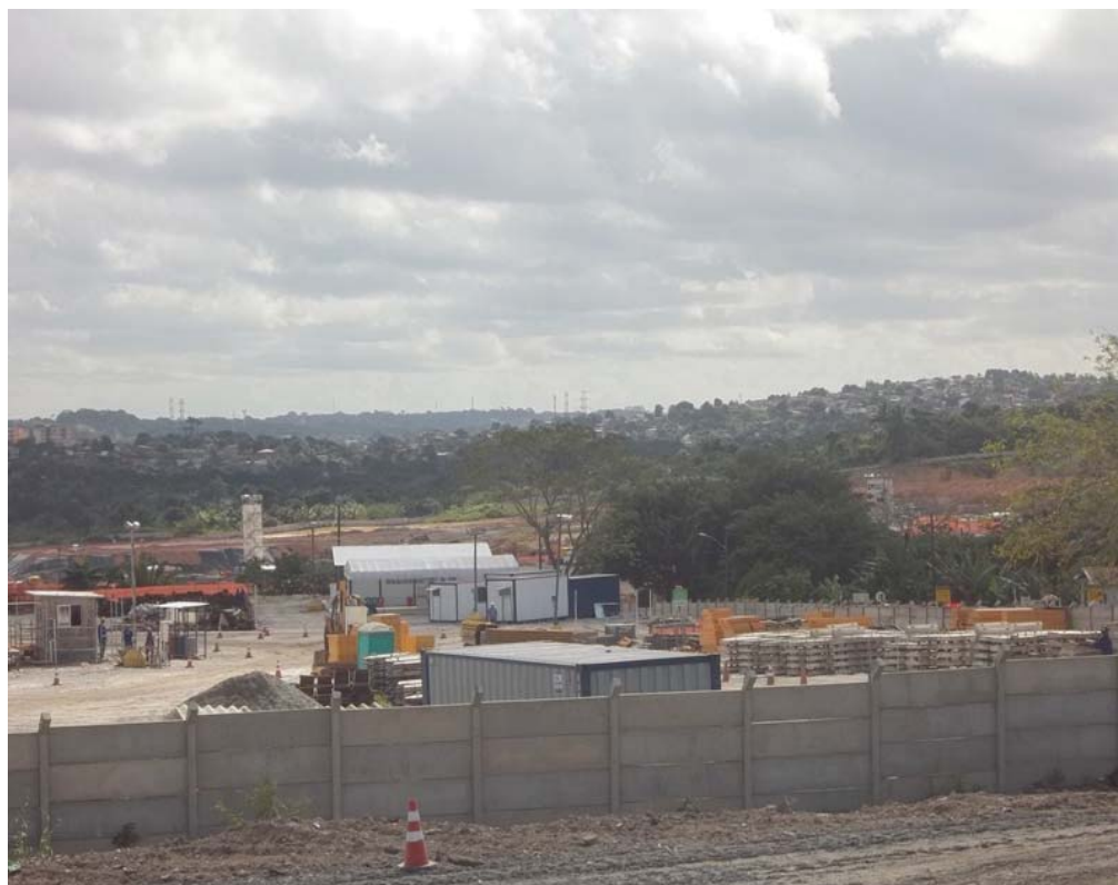
Figura 2 - Arena Pernambuco em construção Fonte: Ísis Andrade de Castro. São Lourenço da Mata-PE/2011
