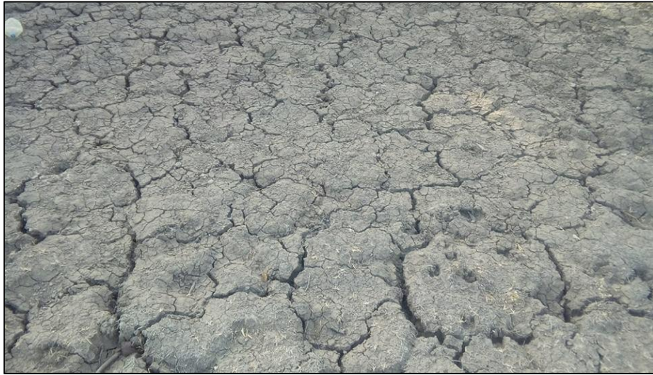
Figura 2 - Presença de gretas de contração.
