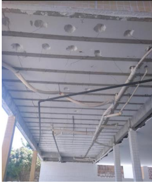
Figura 65 – Tubulação embaixo do refeitório Fonte: Autoria própria (2017).
