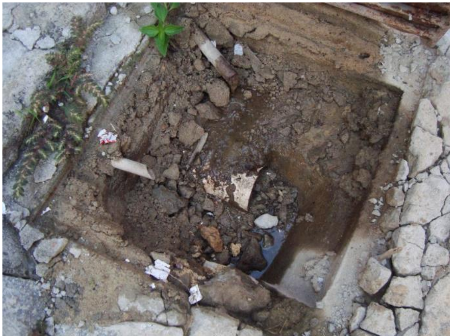
Figura 12 – Caixa de passagem de esgoto
