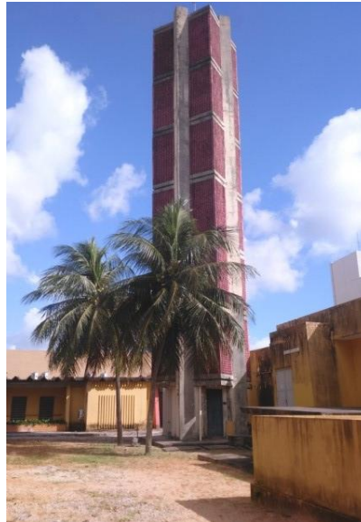
Figura 4 – Reservatório elevado (RE2) Fonte: Autoria própria (2017).
