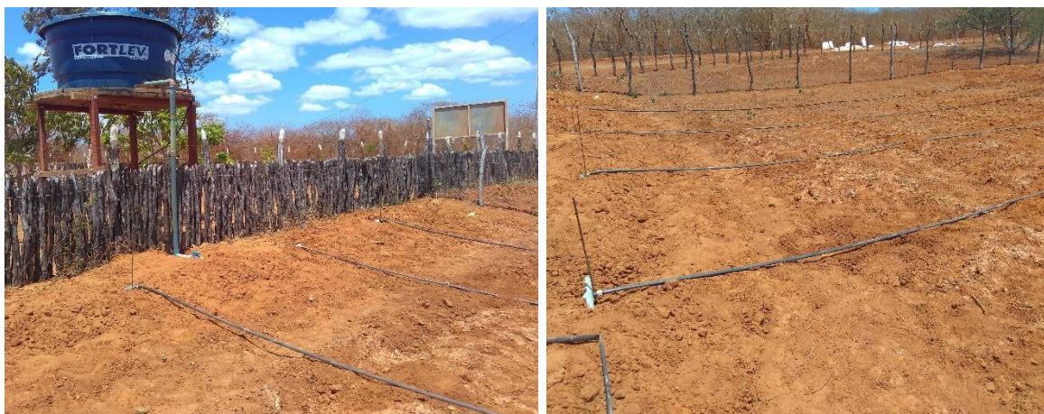
Figuras 3 e 4 – Sistema de irrigação adotado na área experimental.
