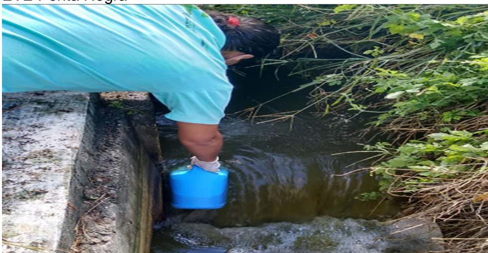
Figura 9 – Caixa de distribuição de vazão da segunda lagoa de maturação da ETE Ponta Negra
