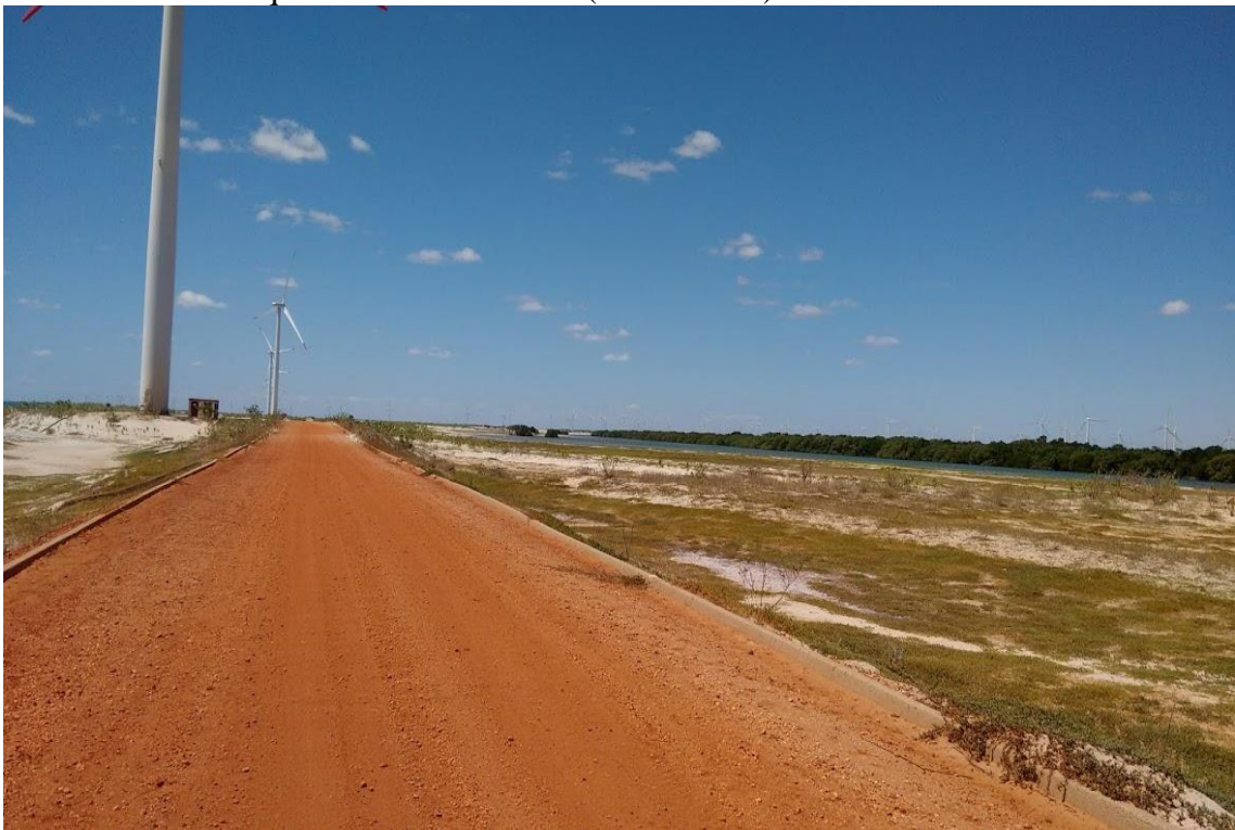
Fotografia 1 – Estrada usada para a passagem de carros na construção e manutenção do Parque Eólico Miassaba 2 (Sertãozinho).
