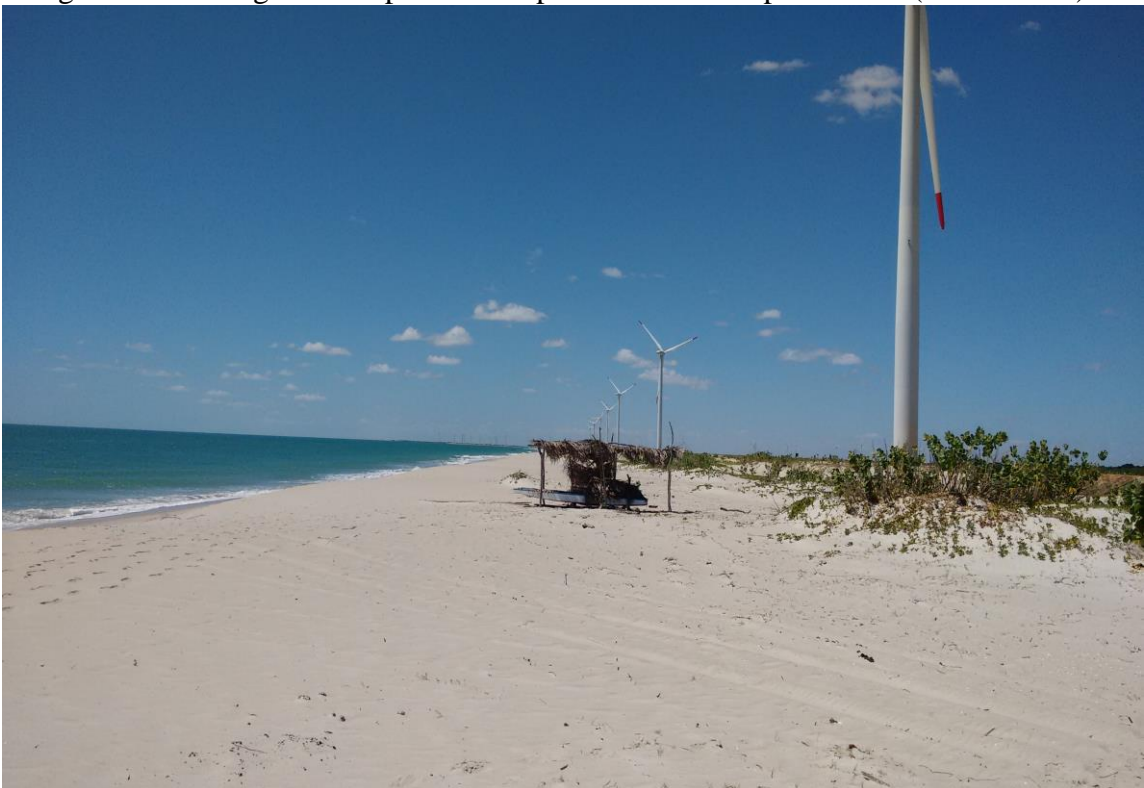
Fotografia 3 – Aerogeradores próximos à praia e rancho de pescadores (Sertãozinho).
