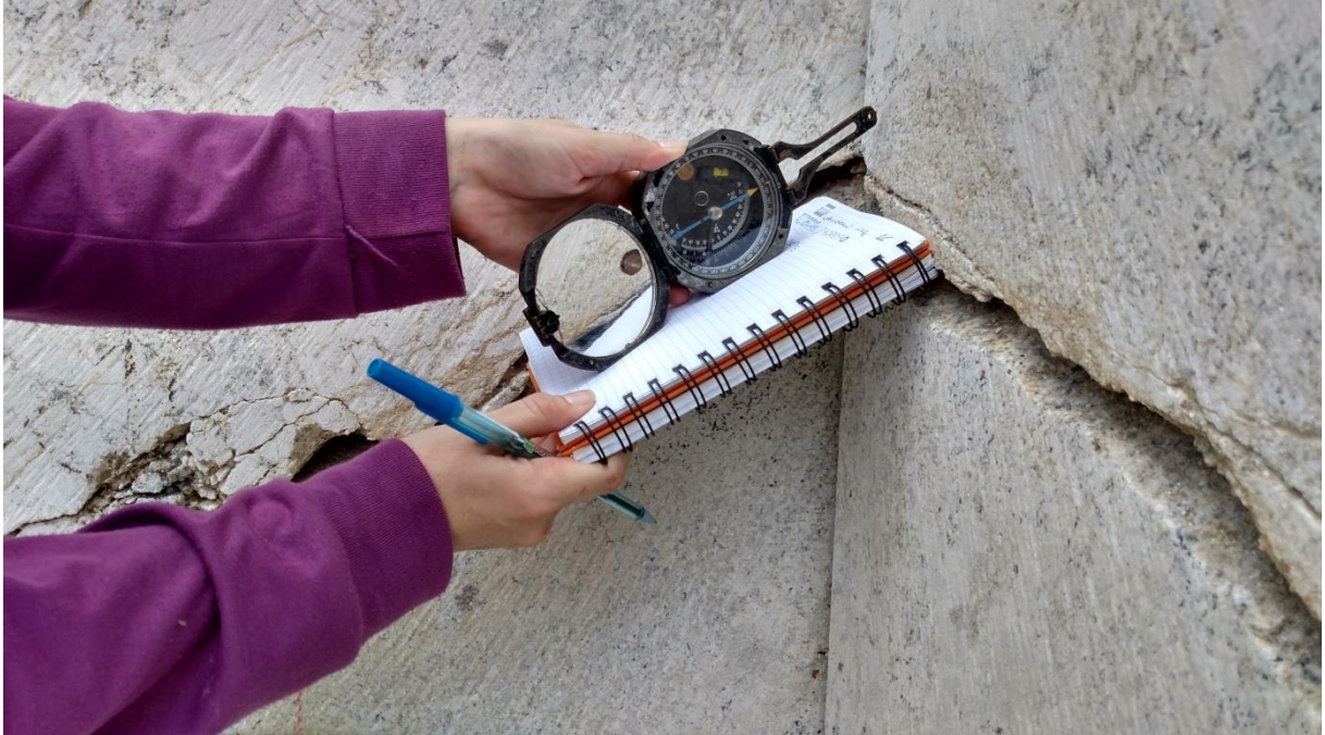
Figura 22 - Frente de lavra e estruturas sendo medidas
