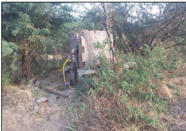
Figura 12 – Poço perfurado no leito do rio cobra para abastecer a comunidade Currais Novos
