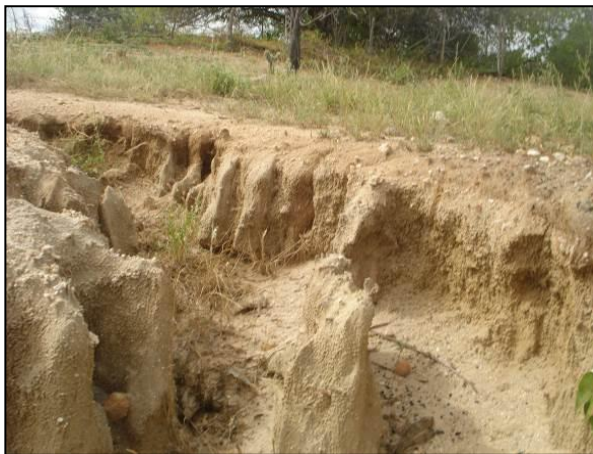
Figura 47 – Erosão provocada pela retirada da mata nativa na comunidade Recanto
