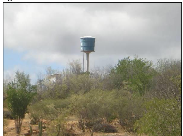
Figura 51 – Sistema de abastecimento de água construído na comunidade Recanto
