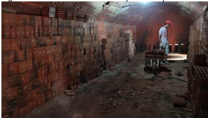
Figura 8. Blocos cozidos defeituosos empilhados na parede do forno
